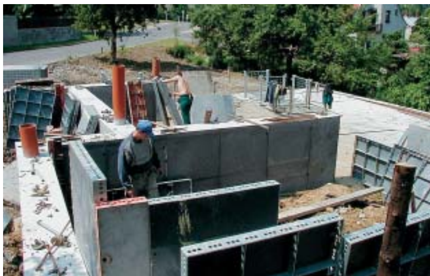
Obr. 1 Pohled na část základové konstrukce při odbedňování Fig. 1 View of a part of the foundation structure during demoulding
