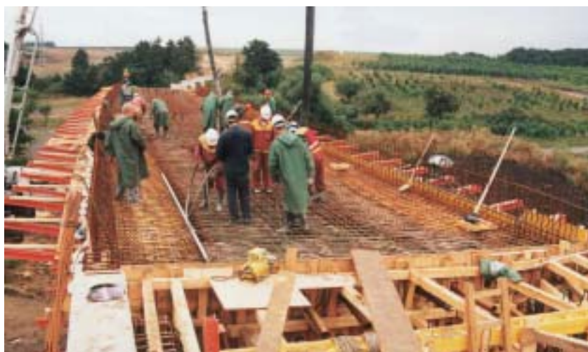
Obr. 3 Betonáž probíhající ze dvou míst – začátek betonáže
