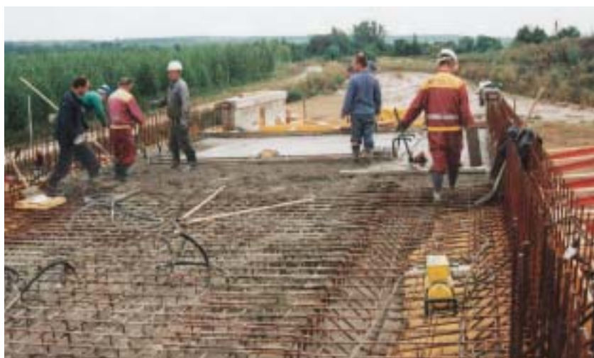
Obr. 5 Způsob úpravy povrchu poslední vrstvy betonu
