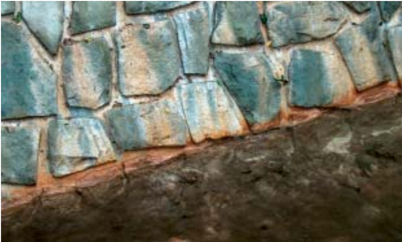
Obr. 2 Obklad břehů potoka Fig. 2 Revetment of brook banks
