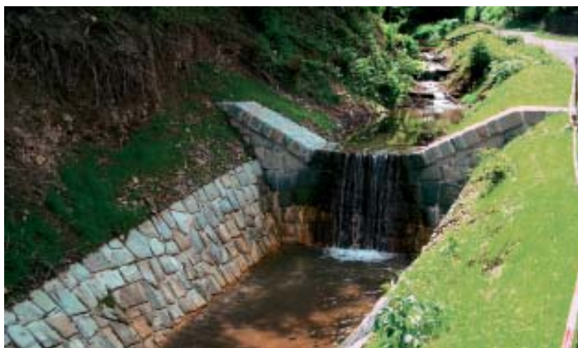
Obr. 1 Pohled na vybudovaný vodní stupeň. Fig. 1 View of the completed drop
