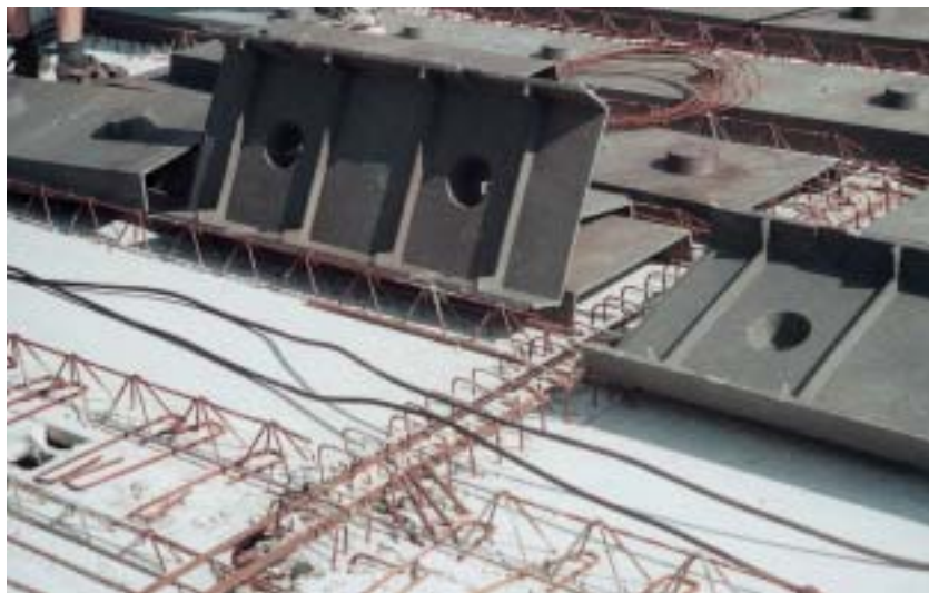
Obr. 5 Vkládání elektrických rozvodů do instalačních dutin
