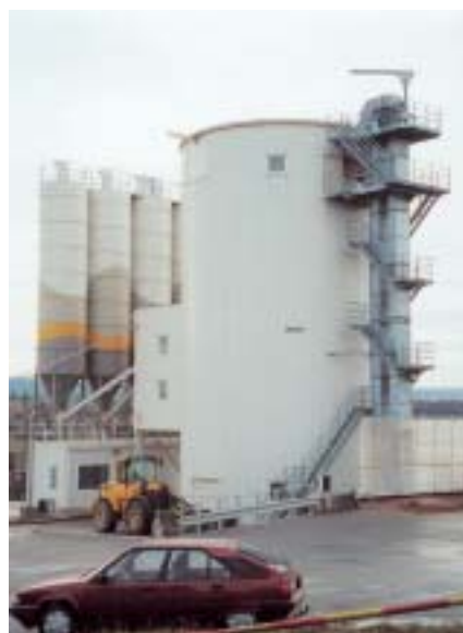
Obr. 1 Celkový pohled na betonárnu TBG BETONMIX, a. s., v Brně-Bosonohách
