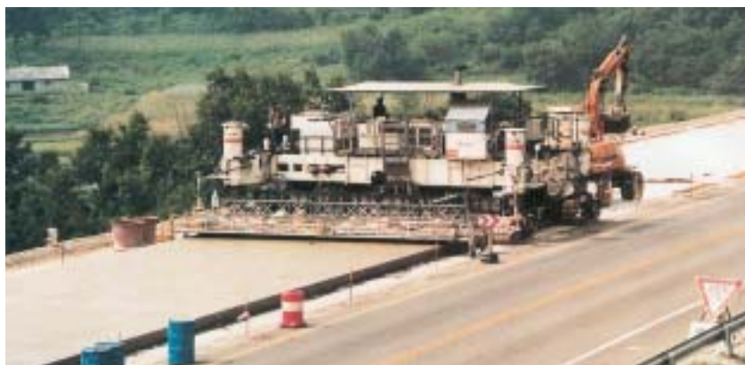
Obr. 1 Moderní finišer pro pokládání cementobetonového krytu ve dvou vrstvách
