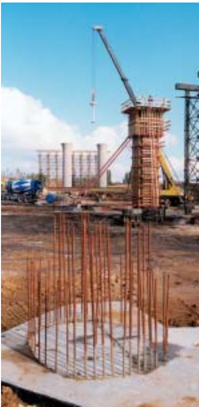
Obr. 4 Výstavba pilířů Fig. 4 Construction of piers
