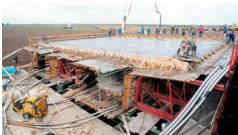
Obr. 7 Betonáž mostního pole na výsuvné skruži
