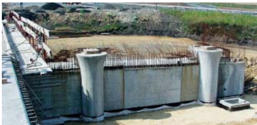
Obr. 5 Výstavba řepské opěry Fig. 5 Construction of the Ropy abutment
