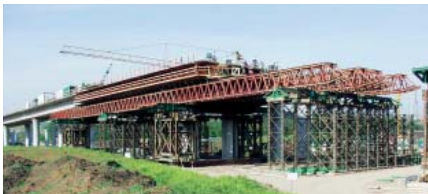
Obr. 6 Výsuvná skruž Röro 2000 Fig. 6 Travelling centering Röro 2000
