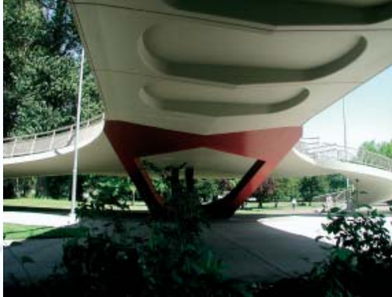
Visutý most přes řeku Willamette, Eugene, Oregon, USA – kotvení visutých kabelů Suspension bridge across the Willamette River in Eugene, Oregon, USA - anchoring of suspension cables
