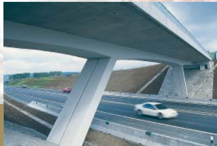
Most z předpjatého pásu přes řeku Rough, Grants Pass, Oregon, USA – vnitřní podpěra Stress-ribbon bridge across the Rough River in Grants Pass, Oregon, USA – intermediate support
