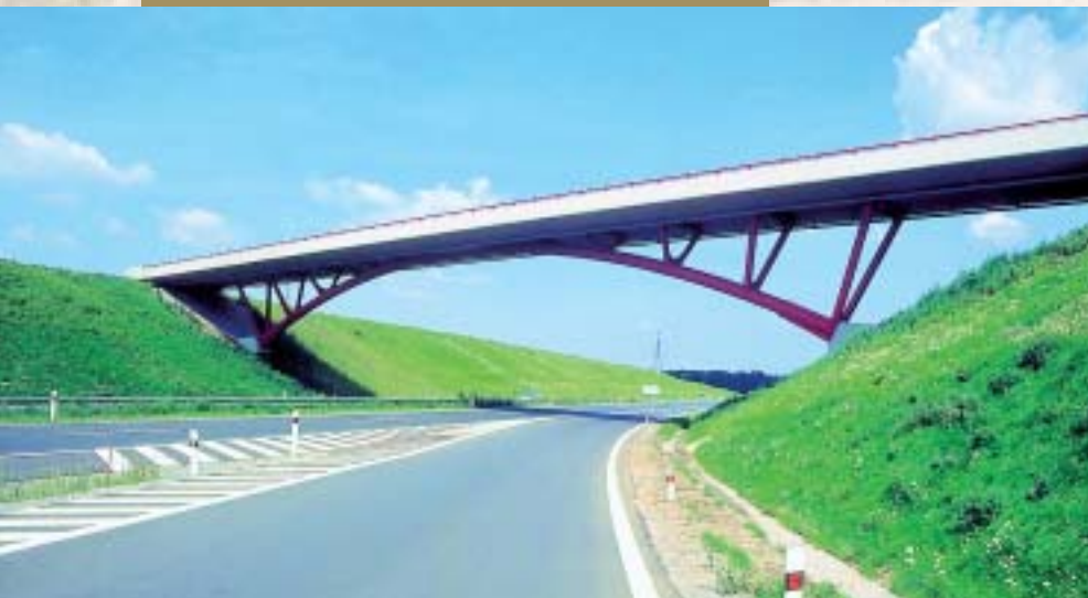
Obloukový nadjezd nad rychlostní komunikací R 52 z Rajhradu do Pohořelic Arch flyover on the freeway R 52 Rajhrad–Pohořelice
