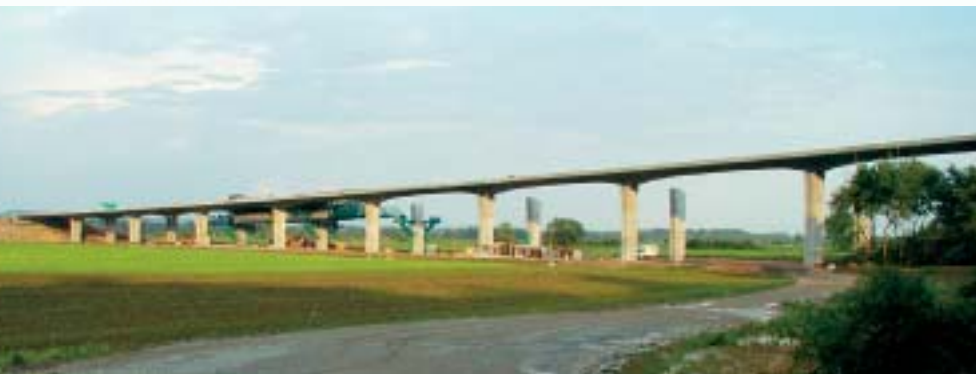
Estakáda na stavbě 3509 – obchvat Olomouce Viaduct on the freeway 3509 near Olomouc
