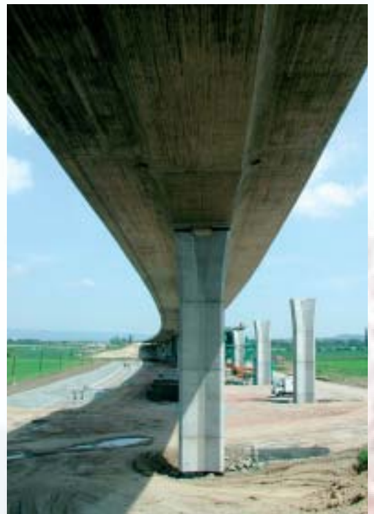
Estakáda na stavbě 3509 – obchvat Olomouce Viaduct on the freeway 3509 near Olomouc
