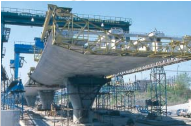
Montáž segmentového mostu přes ul. Mikulášskou v Plzni Erection of the segmental bridge across the Mikulášská street in Plzeň
