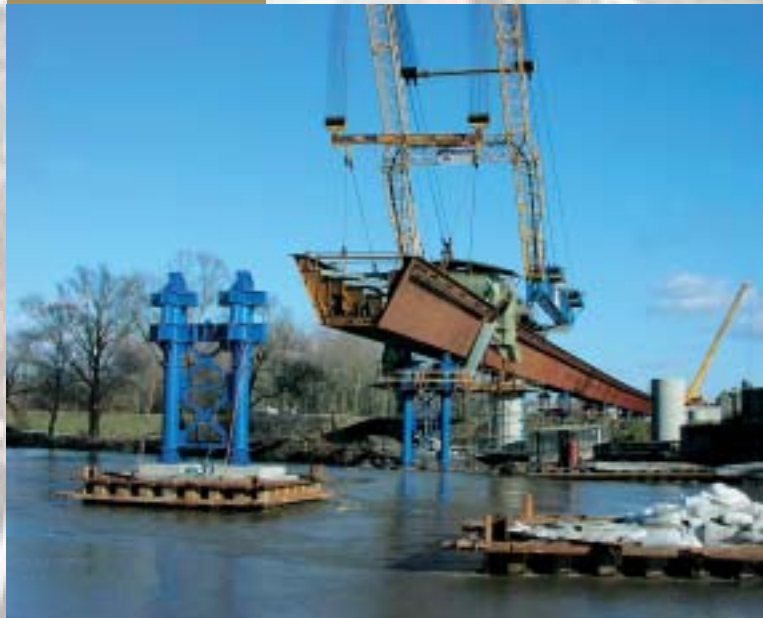
Dálniční most přes Odru – montáž OK ocelových segmentů Freeway bridge across the Odra River – erection of steel segments
