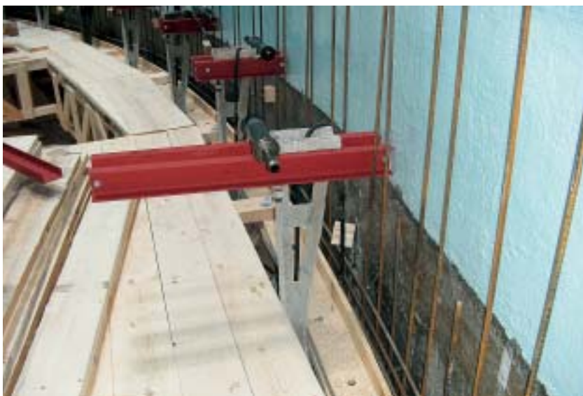
Obr. 9 Výztužná síť vnější stěny a detail zařízení posuvného bednění
