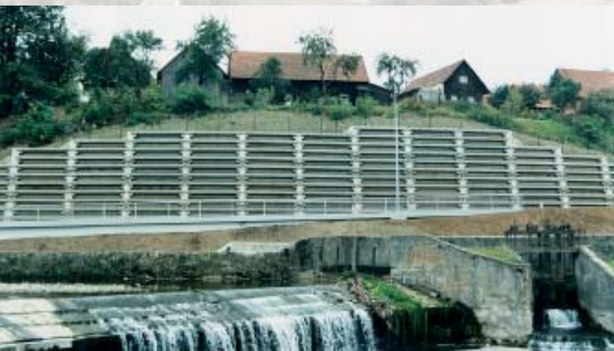
Silnice II/487, Halenkov – zárubní zeď Road II/487, Halenkov – retail wall
