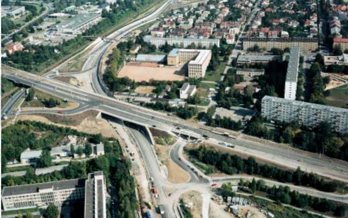
VMO Brno, mosty na Lesnické ulici LTRR Brno, bridges in Lesnická street
