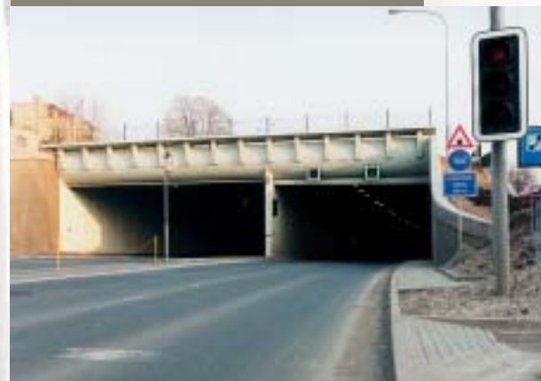
Velký městský okruh Kohoutova, severní portál tunelu Large town ring Kohoutova, north portal of the tunnel
