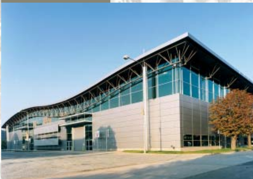
Pavilon V, Brno–Výstaviště Exhibition pavilion V, Brno–Výstaviště
