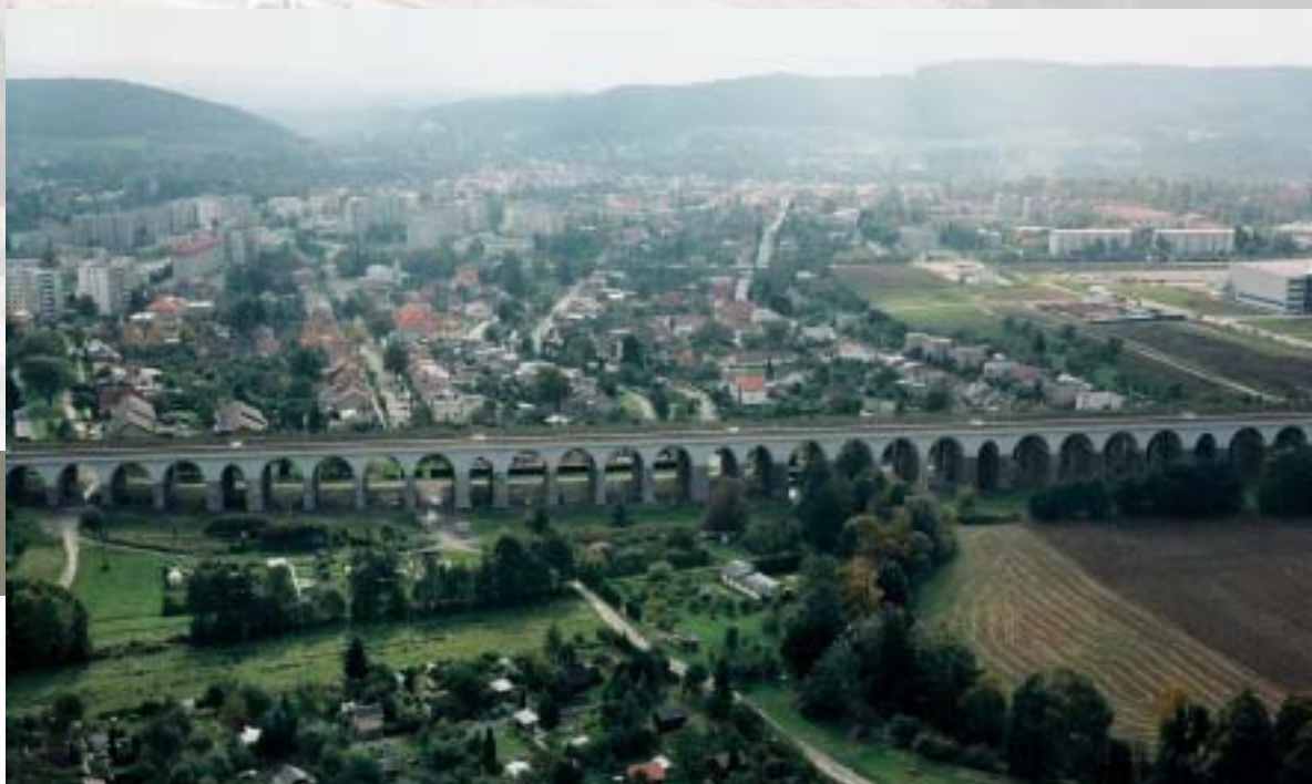
Hranický viadukt – rekonstrukce v roce 2000 Reconstruction of the viaduct in Hranice in year 2000
