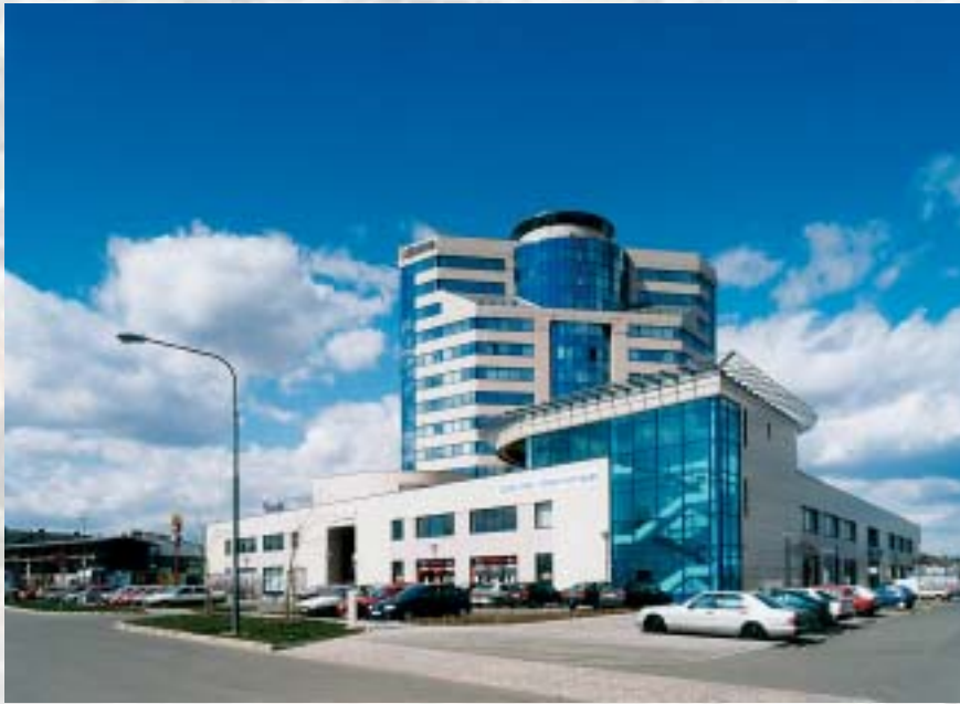
M-palác obchodně administrativní centrum Brno M-palace, commercial and administrative centre
