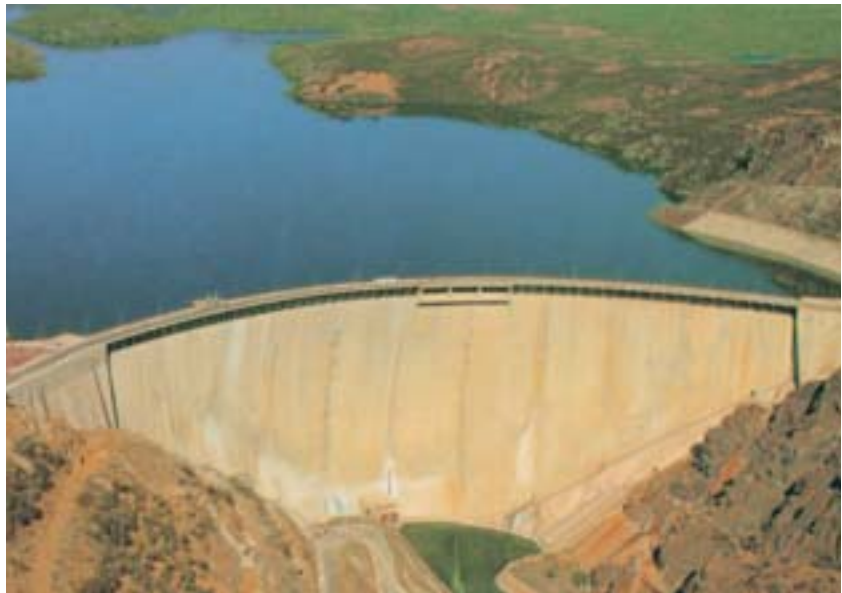
El Atazar na řece Lozoya, rok výstavby 1972, výška 134 m, klenbová přehrada (podloží sanováno systémem kotev), objem nádrže 426 · 10 6 m 3
