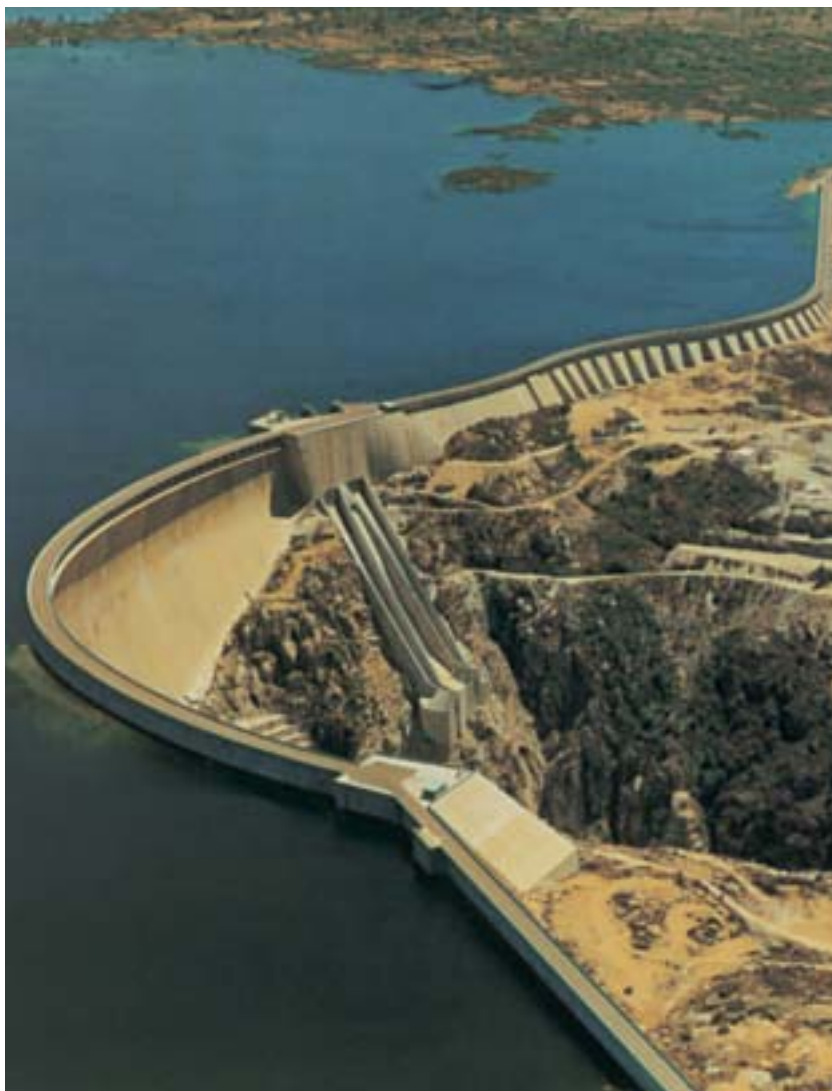
Almendra na řece Tormes, rok výstavby 1970 výška 202 m, klenbová přehrada s navazujícími betonovými hrázemi různé konstrukce, objem nádrže 2 648 · 10 6 m 3
