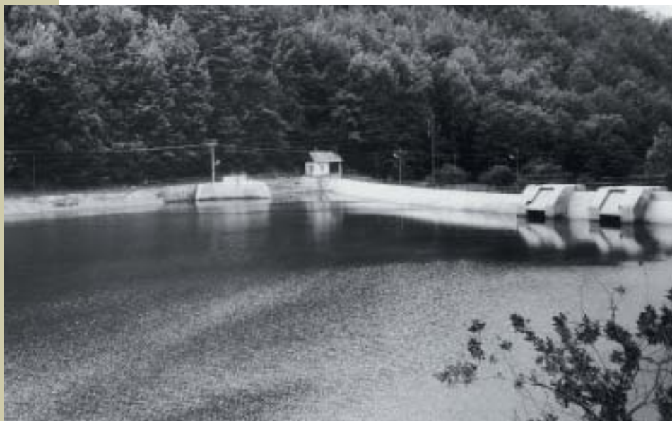
Obr. 4 Pohľad na priehradu Dolný Jelenec návodná strana
