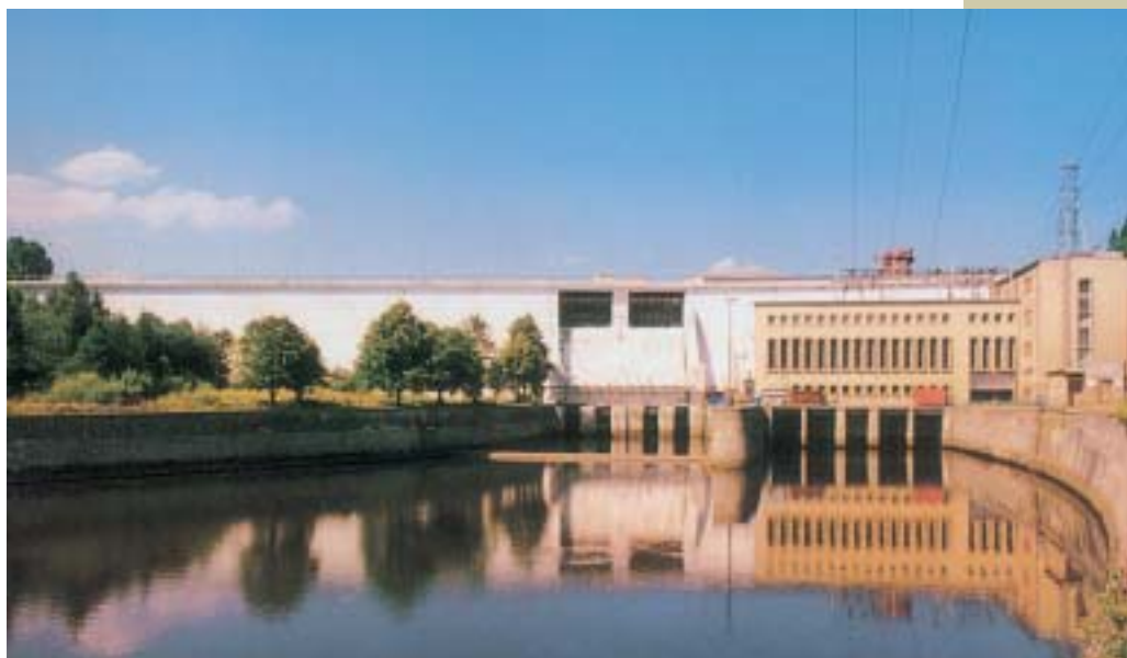
Obr. 3 Pohľad na priehradu Orava s podpriehradovou vodnou elektrárnou
