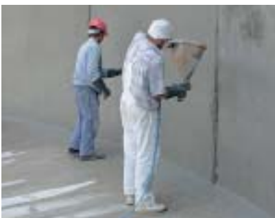
Obr. 5 Stříkání krystalizace – 1. fáze
