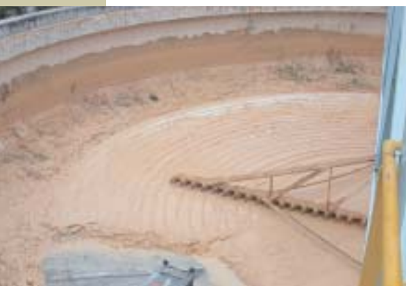
Obr. 2 Nádrž DOOR C po vypuštění Fig. 2 Basin DOOR C after discharge
