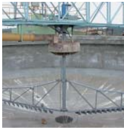
Obr. 6 Pohled na opravená hrabla a krystalický nástřik stěny H-Krystalem před napouštěním
