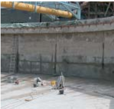
Obr. 4 Částečně vysekané spáry s prvním nástřikem krystalizace
