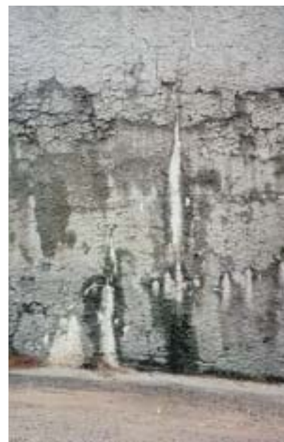
Obr. 3 Usazeniny vyplavovaného vápnicku Fig. 3 Sediments of outwashed lime
