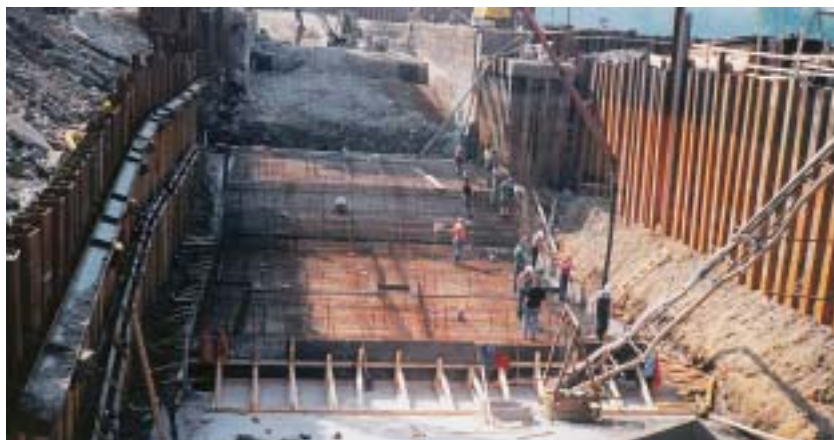
Obr. 3 Pohled do bývalé vorové propusti. V popředí probíhá betonáž základové desky elektrárny
