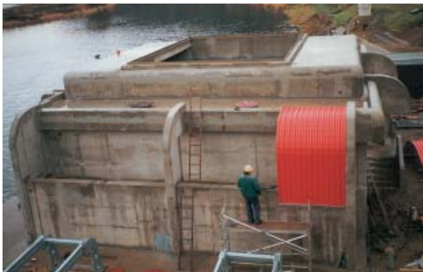
Obr. 2 Počátek montáže střechy na dokončenou železobetonovou konstrukci vrchní stavby elektrárny. Zcela nahoře je otvor střešního světlíku, který slouží také pro montáž technologické části
