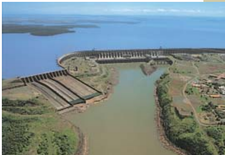
Obr. 1 Vodní dílo Itaipu na řece Paraná, Brazílie, výška přehrady 196 m, instalovaný výkon 12 000 MW
