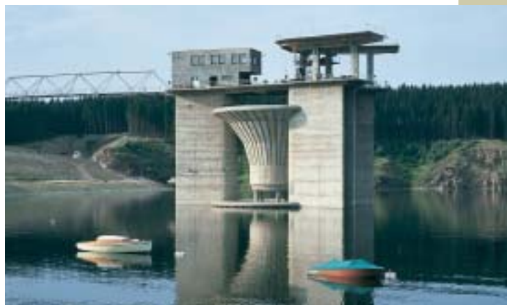
Obr. 3 Sdružený manipulační objekt přehrady Želivka (přeliv, výpust, odběr vody)
