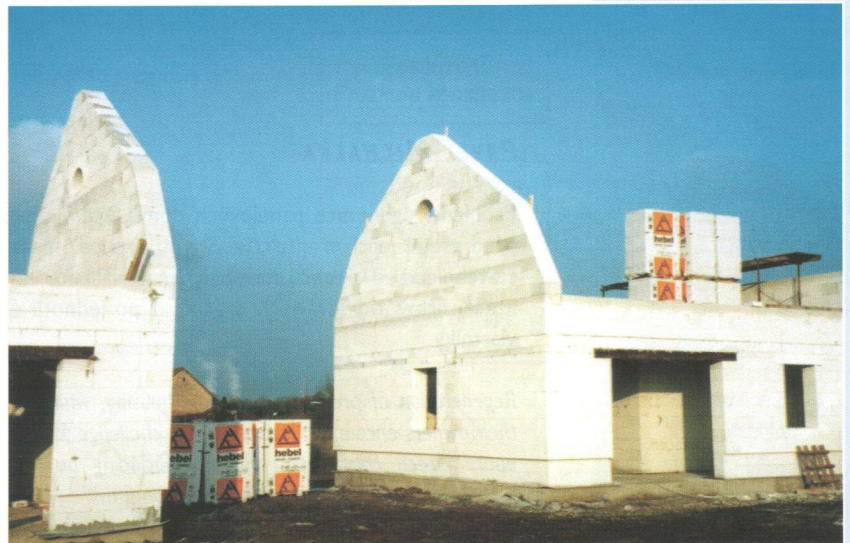
Obr. 3 Hebel Porobeton- systém pro celou hrubou stavbu
