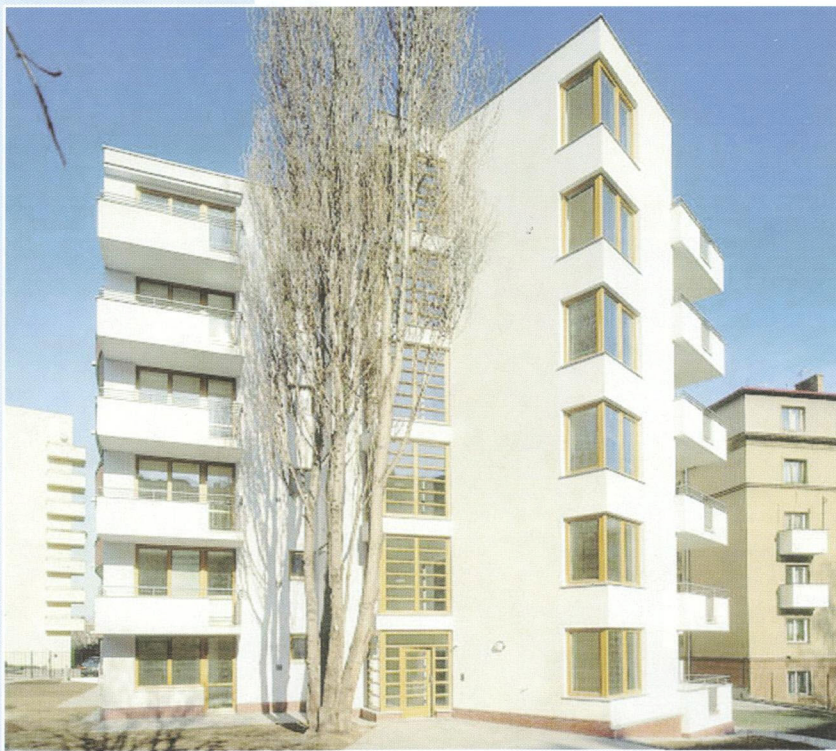
Obr. 1 Bytový dům s pečovatelskou službou – Šlejnická ulice, Praha 6 – Dejvice
