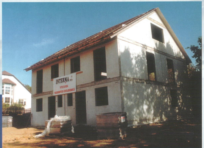
Liberec, panelový rodinný domek před dokončením
