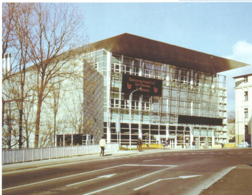
zařízení budov spolupracuje SIAL převážně s kanceláří SIL, s.r.o., která sídlí v tomtéž objektu.
