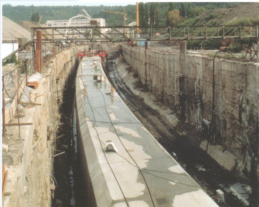
Obr. 4 Téměř dobetonovaný tunel
