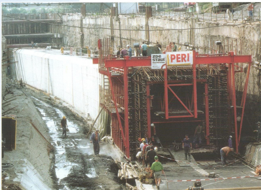
Obr. 2 Pohled na posuvné bednění zředu.
