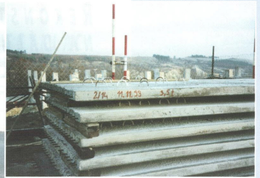
Obr. 1 Předem předpjaté desky před spřažením
