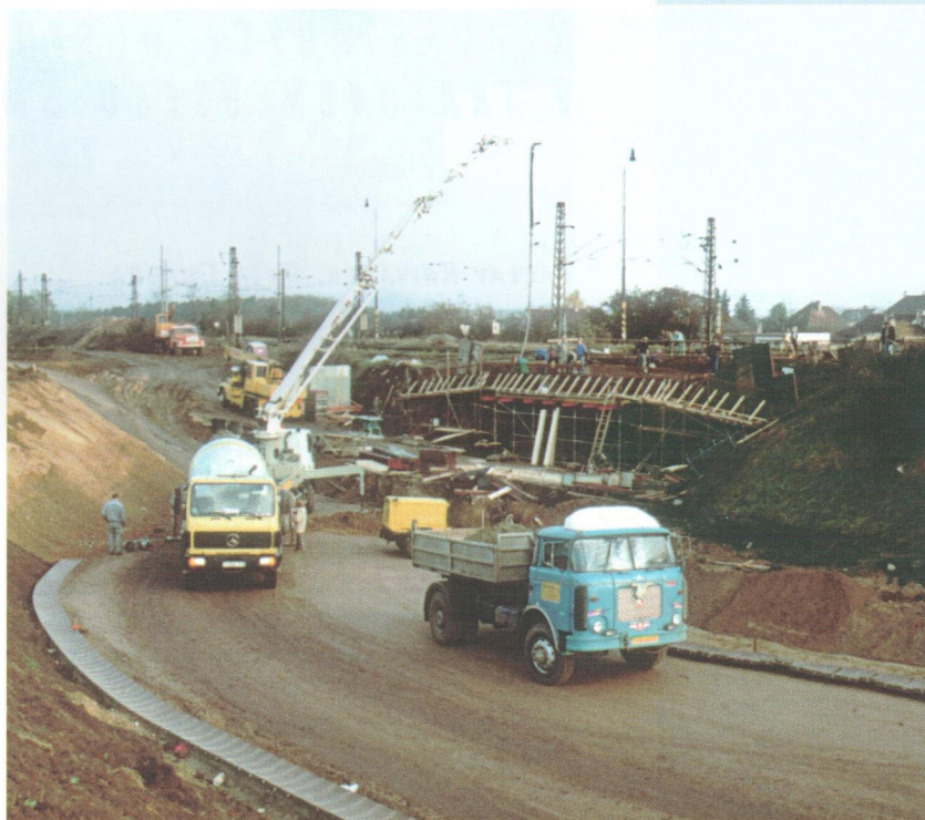
Obr. 2 Průběh betonáže
