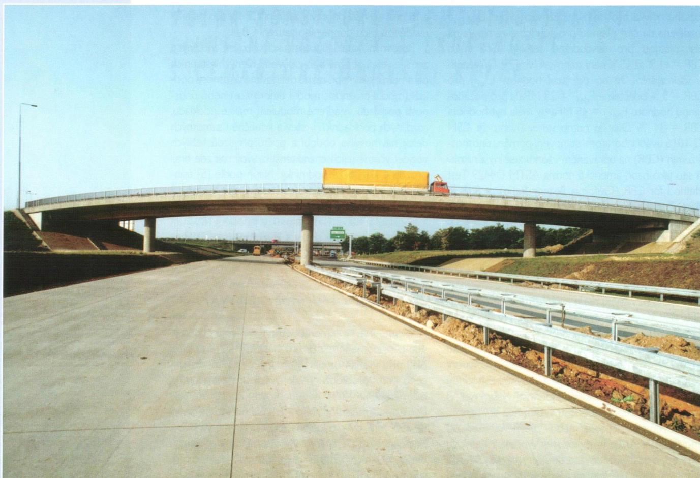
Silniční okruh kolem Prahy, úsek Třebonice – Řepy
