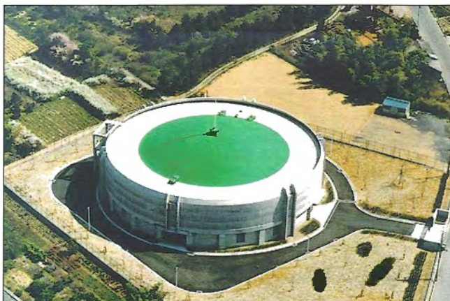
Obr. 1 – Ukázka železobetonové konstrukce vodojemu / Reinforced concrete structure of tank
