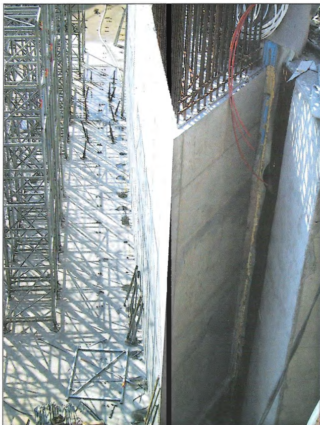
Obr. 5 – Ostrá hrana stěny / Sharp edge of the wall
