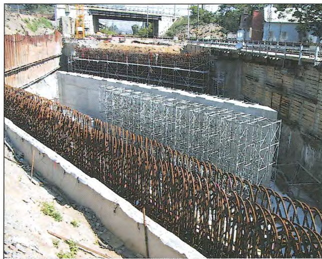
Obr. 6 – Spodní stavba mostu před montáží bednění pro horní desku / Bridge substructure before the assembly of the formwork of the bridge deck
