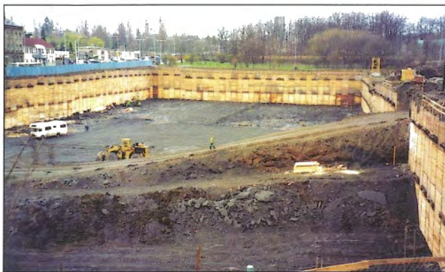
Obr. 8 – Stavební jáma - hloubka 9 - 12 m; Půdorysné rozměry 207 × 76 m / Foundation pit - depth 9 to 12 m; Ground plan dimensions 207 × 76 m
