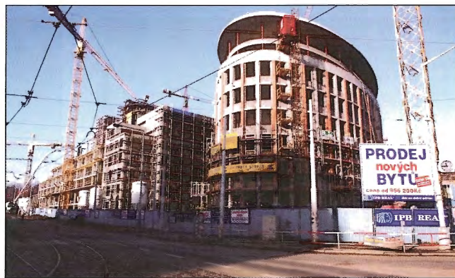
Obr. 9 – Celkový pohled z Vinohradské ulice / Overall view from Vinohradská Street
