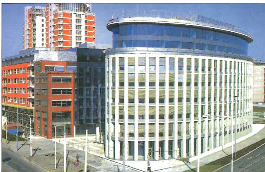
Obr. 1 – Komerční centrum Vinice – celkový pohled / Commercial Centre Vinice – general view
