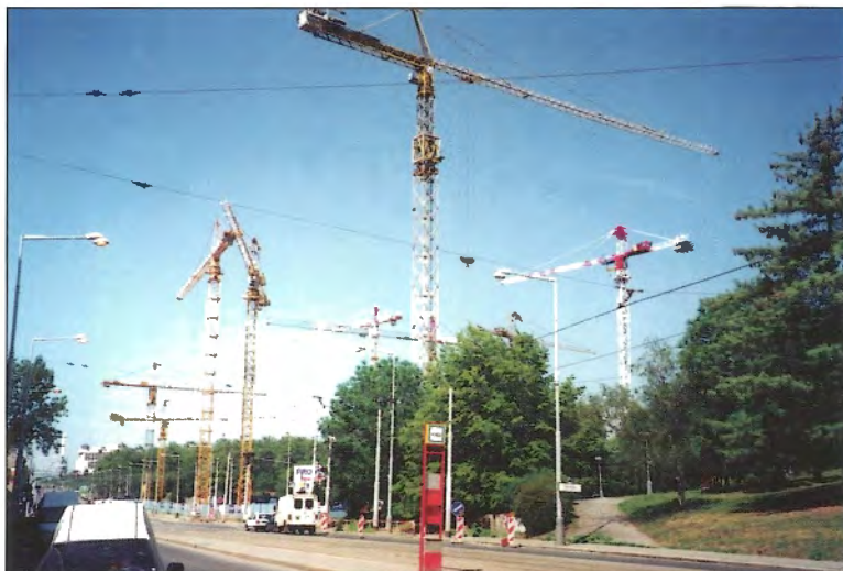
Obr. 17 – Devět jeřábů se sklání nad stavební jámou. Zbývá uložit 50 000 m 3 betonu. / Nine cranes leaning over the foundation pit. 50.000 cubic metres of concrete remain to be placed.
