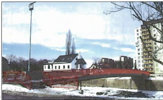
Obr. 6 – Lávka pro pěší – Celkový pohled / Pedestrian bridge – General view
