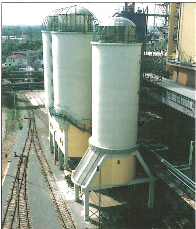
Obr. 3 – Sila pro expedici produktů provozu a odsáření v Plzeňské teplárně, a.s. / Waste disposal reinforced concrete tower silos of the Pilsner heating plant
