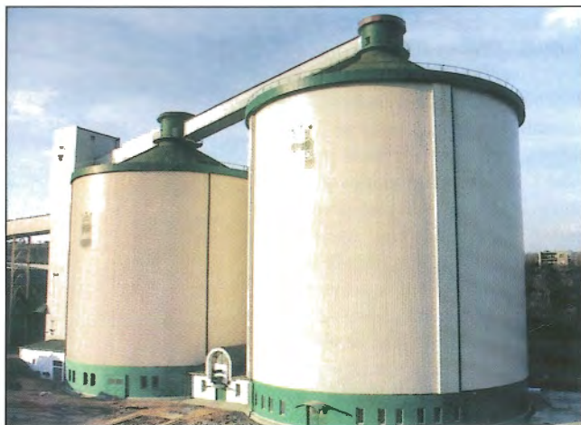
Obr. 4 – Silo na cukr o kapacitě 30 000 t v cukrovaru TTD Dobrovi- ce / Prestressed sugar silo in Dobrovice
