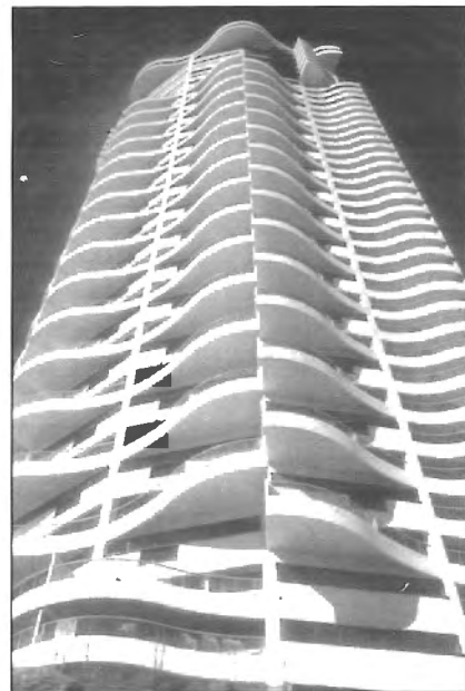
Obr. 3 – Zakřivené balkony charakteristické pro jedinečný ráz budovy / Curved balconies as a characterising the uniqueness of the building
