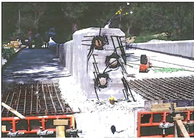
Obr. 10 – Most v Jaselské – Kotevní oblast / Bridge at Jaselská – Anchorage zone
