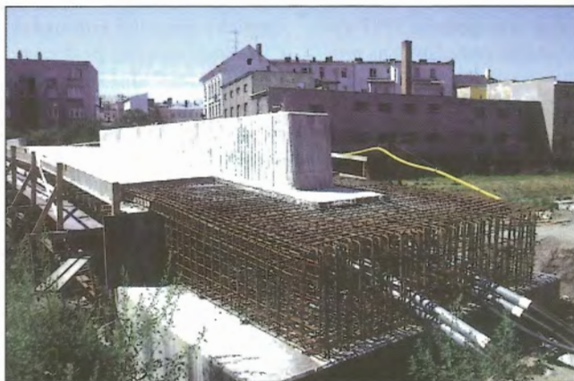
Obr. 5 – Lávka pro pěší – Zmonolitnění nosné konstrukce / Pedestrian bridge – Cast closure of superstructure
