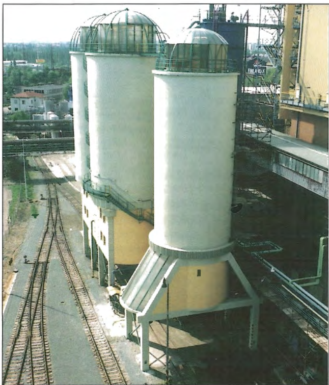
Obr. 3 – Sila pro expedici produktů provozu a odsáření v Plzeňské teplárně, a. s. / Waste disposal reinforced concrete tower silos of the Pilsner heating plant
