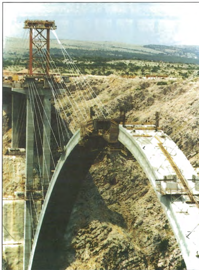
Obr. 1 – Fáze výstavby oblouku mostu Maslenica před uzavřením jeho vrcholu / View of the Maslenica bridge prior to arch closure
