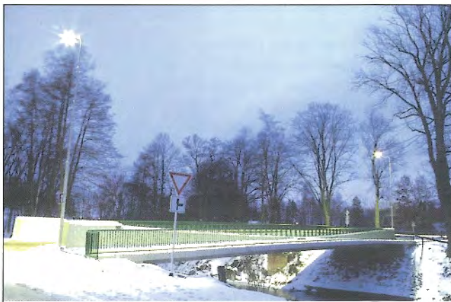
Obr. 11 – Most v Jaselské – Most po dokončení / Bridge at Jaselská – Completed bridge
