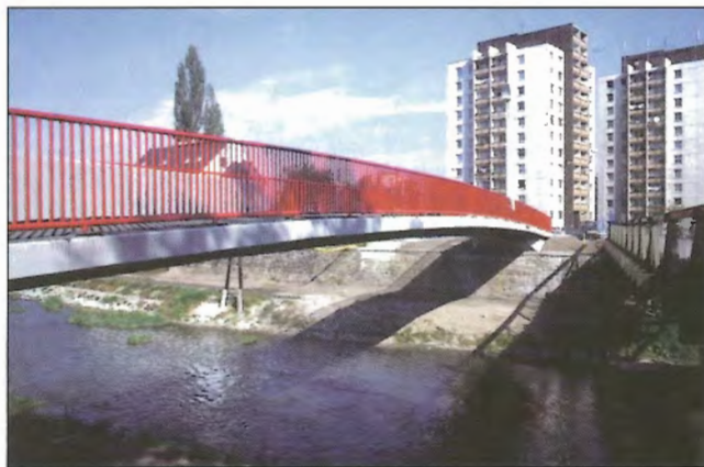
Obr. 4 – Lávka pro pěší – Hlavní pole / Pedestrian bridge – Main span
