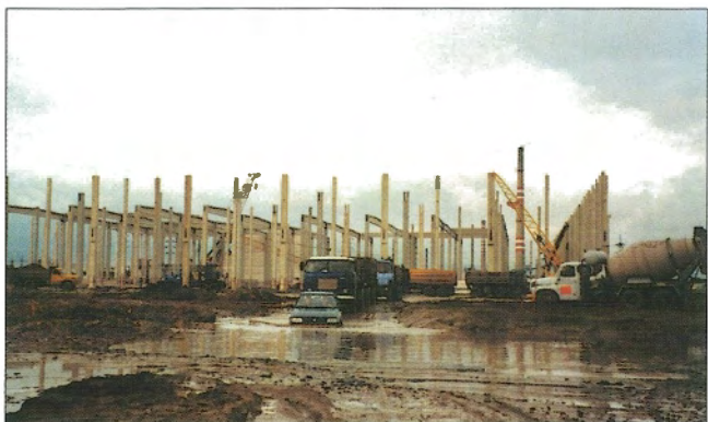
Obr. 2 – Celkový pohled na rozestavěnou halu / General view of the hall in the process of construction
