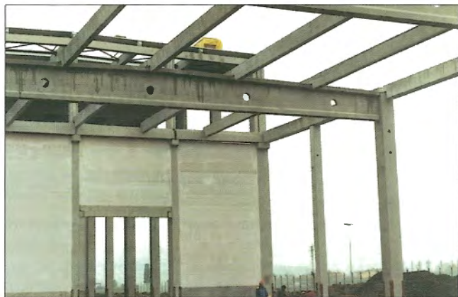
Obr. 7 – Soklové dílce a nadpraží požárních stěn ze železobetonu, ostatní stěnové dílce z lehčeného betonu / Base components and the cap of reinforced concrete walls, and other wall components from cellular concrete
