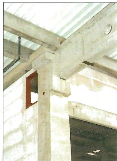
Obr. 5 – Sloup po osazení navazujících prvků / Column for embedding of joining elements
