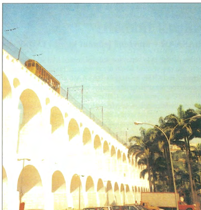
Obr. 4 – Arcos da Lapa – akvadukt z roku 1732 nyní sloužící jako most pro historickou tramvajovou linku Santa Teresa / Arcos da Lapa – aqueduct from 1732 is now used as a bridge for historical tram line Santa Teresa
