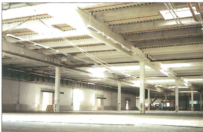
Obr. 11 – Interiér haly před dokončením / Interior of the hall before finishing
