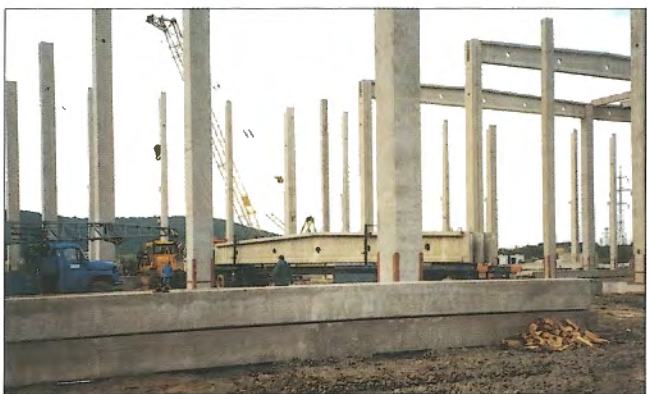
Obr. 9 – Osazování předpjatého vazníku / Seating of the pre-stressed joining balk
