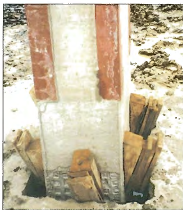
Obr. 8 – Dřík sloupu před zabetonováním / Shank of the column before concrete encasement
