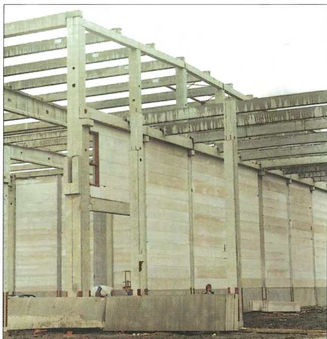
Obr. 6 – Krajní pole haly - střešní trámy ve dvou výškových úrovních s osazenými vaznicemi / Abutment span of the hall - roof beams in two height levels with embedded purlins
