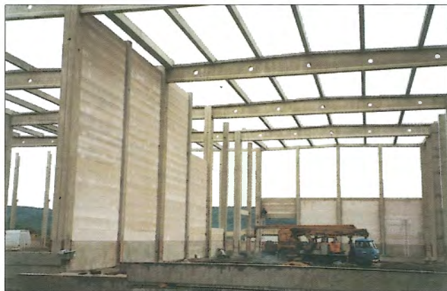
Obr. 10 – Pohled na část smontované nosné konstrukce haly / View of a part of the assembled bearing structure of the hall
