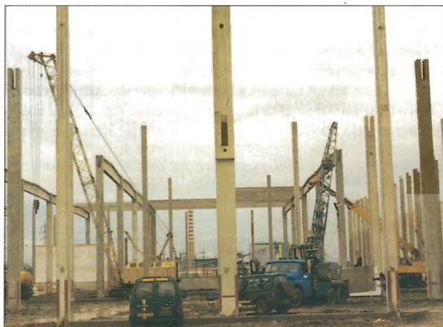
Obr. 3 – Sloupky s vidlicemi ve dvou výškových úrovních pro osazení vazníků / Columns with forks in two height levels for the seating of joining balks
