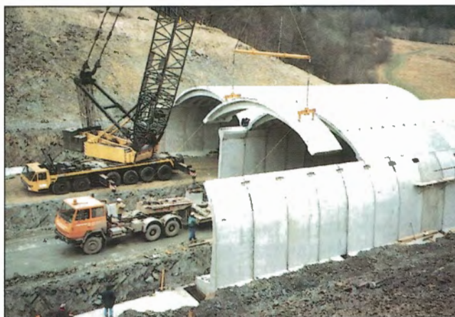
Obr. 2 – Montáž konstrukce / Assembly of structure
