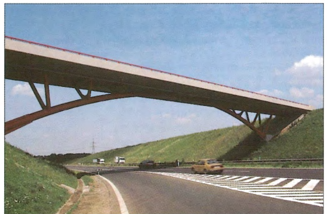
Obr. 31 – Dokončená konstrukce / Completed structure
