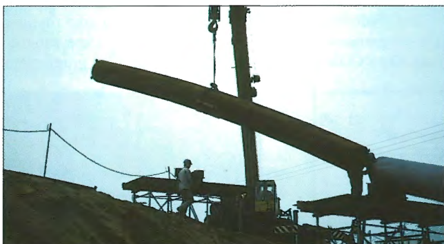
Obr. 19 – Montáž obloukového segmentu / Erection of an arch segment
