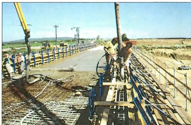
Obr. 21 – Betonáž mostovky / Casting of the deck
