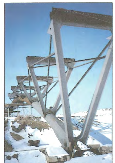
Obr. 16 – Oblouk a vzpěry / Arch and struts
