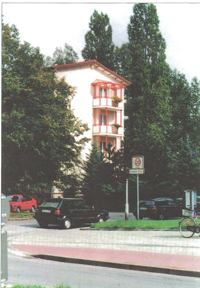
Obr. 7 – Ocelová předsazená lodžie / Self-supporting steel loggia
