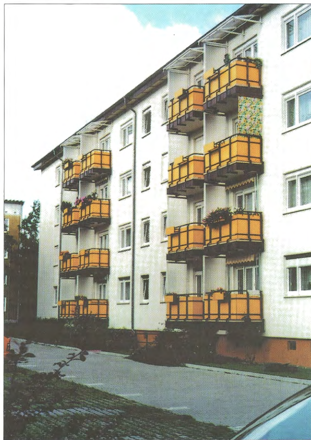
Obr. 9 – Nové zavěšené balkóny / Newly suspended balconies
