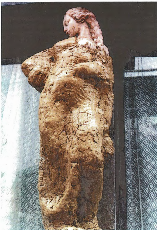
Obr. 2 – Ochrana sochařské výzdoby během obnovy fasády / Protection of the statuary decoration in the process of the facade renovation
