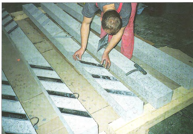
Obr. 1 – Pohled na prováděné zesilování CFK lamelami / View of the strengthening of CFK strips
