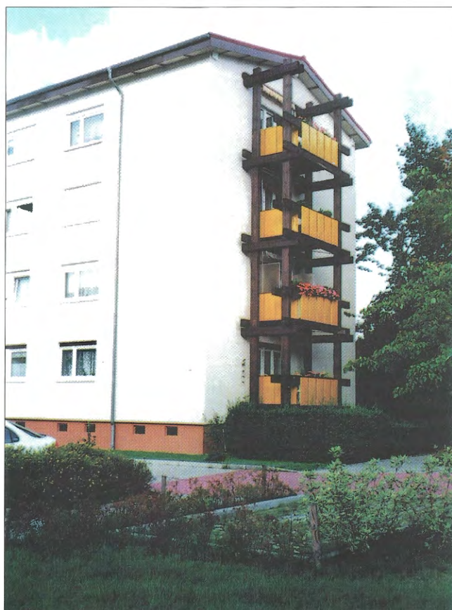
Obr. 3 – Původně zavěšené balkóny jsou nahrazovány předsazenou nosnou konstrukcí / Replacement of the original suspended balconies by a spatial load-bearing frame structure
