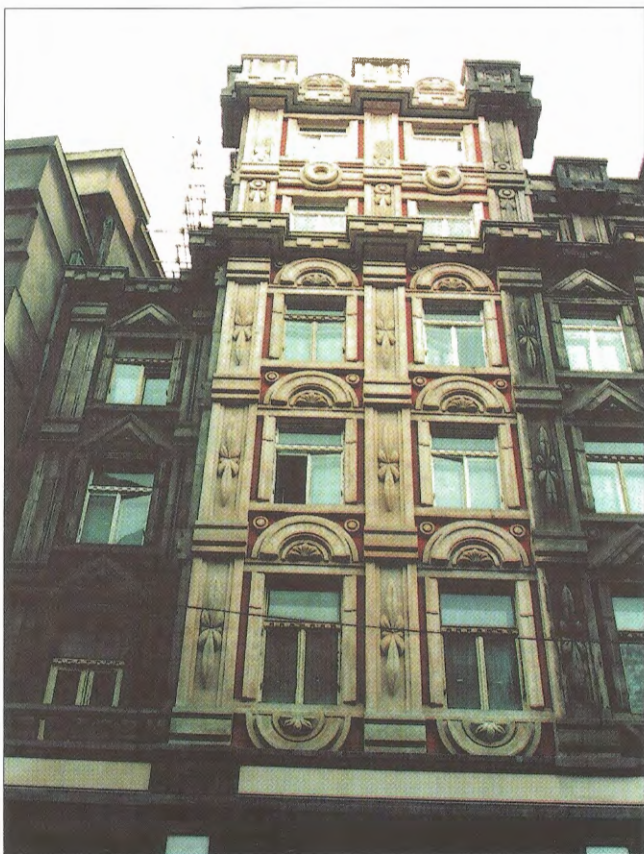
Obr. 3 – Kontrast původní a obnovené fasády / Contrast between original and renovated facade.
