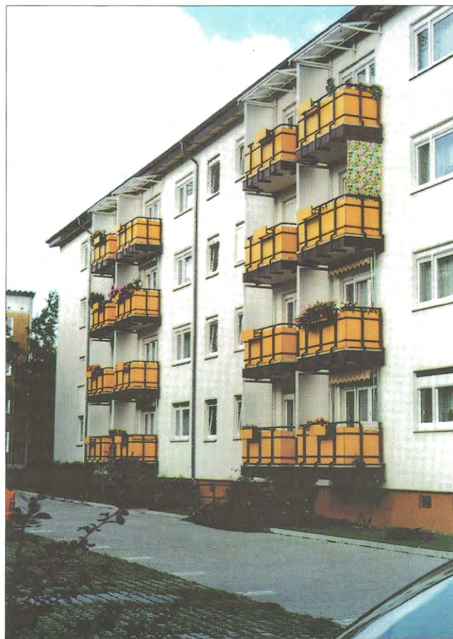
Obr. 9 – Nové zavěšené balkóny / Newly suspended balconies
