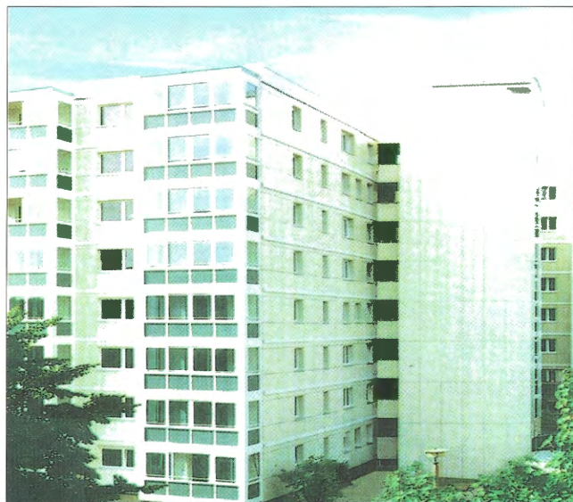
Obr. 2 – Revitalizovaný původní jedenáctipodlažní objekt, tři patra byla snesena, neboť stávající požární předpisy pro vícepodlažní objekty jedenáctipodlažní dům nesplňoval / Three floors of the original 11-floor construction were removed since the construction had not complied with the existing fire protection regulations
