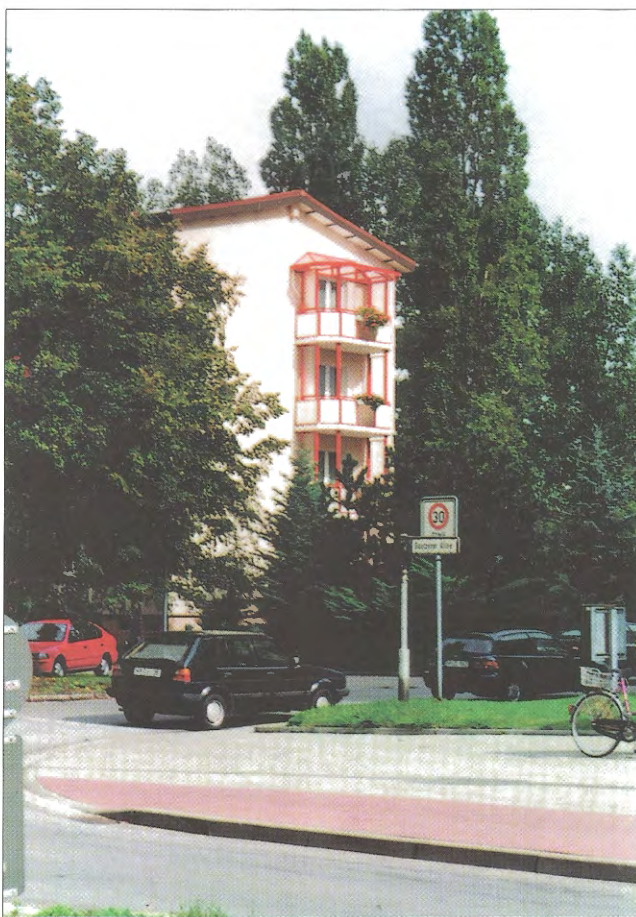
Obr. 7 – Ocelová předsazená lodžie / Self-supporting steel loggia
