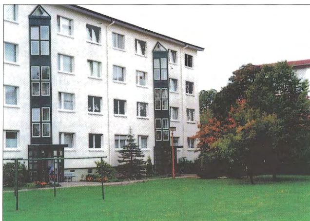
Obr. 6 – Ztvárnění fasády prospěje i úprava schodišového prostoru / Adaptation of a staircase improves facade appearance
