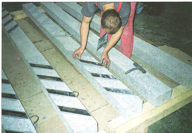
Obr. 1 – Pohled na prováděné zesilování CFK lamelami / View of the strengthening of CFK strips
