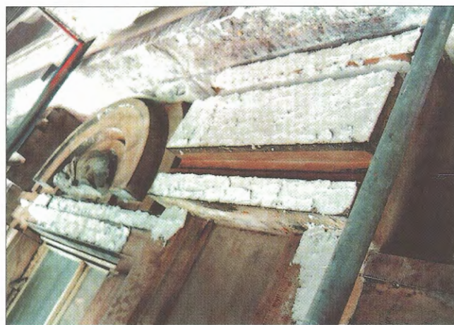
Obr. 4 – Provádění restaurátorských prací na fasádě / Execution of facade renovation
