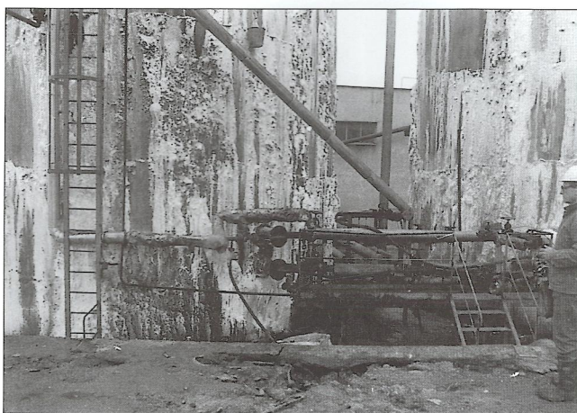
Obr. 8 – T. Vaněk: Poněkud méně „kvalitní“ pracovní spáry sodejmu. Soda proniká na vnější líc, kde krystalizuje. Sanovalo se to vnitřním plechovým opláštěním / Working joints in a caustic soda tank; internal steel sheathing was used
