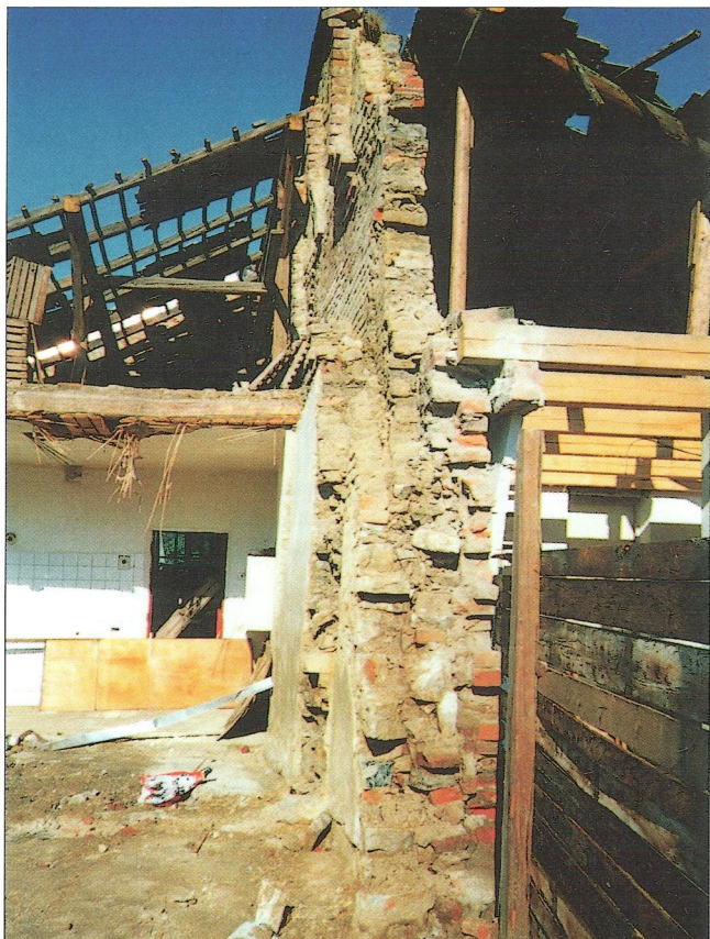
Obr. 3 – J. Vrba: Dilatační spára mezi dvěma objekty řadové zástavby v okrajové čisti Olomouce. Jde o místo zasažené povodní v roce 1997. Majitel parcely vlevo trvá na zbourání celé zdi jeho objektu a majitel vpravo naopak chce nemovitost opravit. Celé je to nesmysl, neboť i na fotografiích je patrné, že pod zdí není izolace proti zemní vlhkosti. Sotva se najde někdo, kdo dokáže zeď objektu vlevo bezkonfliktně odbourat / A nonexistent expansion joint between two buildings damaged by floods in 1997. One of the owners intends to dismantle „his“ wall.
