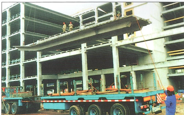
Obr. 13 – Montáž panelů TT parkingu Akademické nemocnice v Leiden / Assembly of TT units. Car park of Academic Hospital in Leiden
