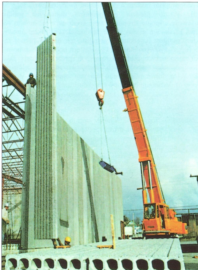
Obr. 9 – Architektonické stěnové dutinové panely obvodového pláště s žebrovou profilací vnějšího povrchu – USA / Ribbed exposed aggregate architectural wall panels – USA
