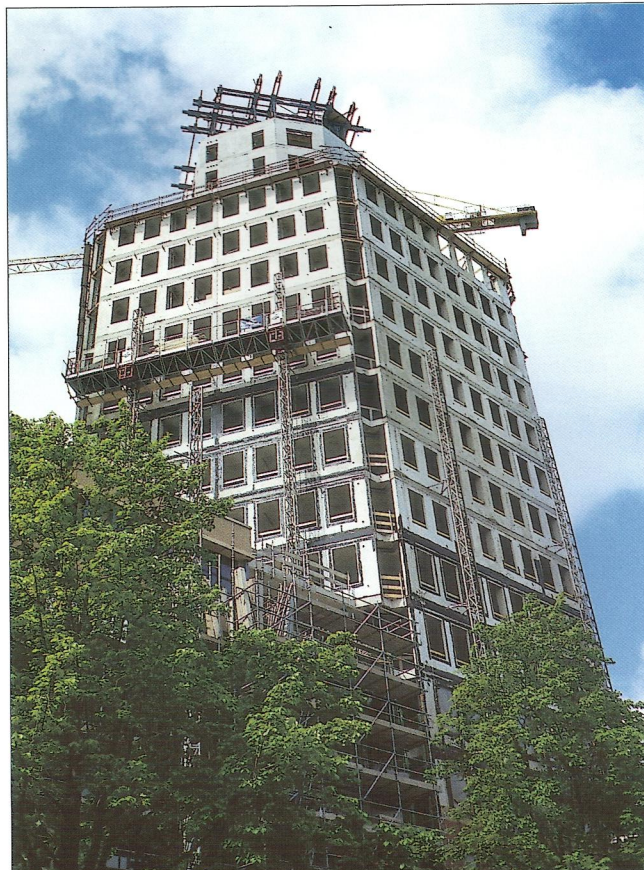
Obr. 17 – Hybridní konstrukce při výstavbě v Haagu / A hybrid skeleton under construction in The Hague
