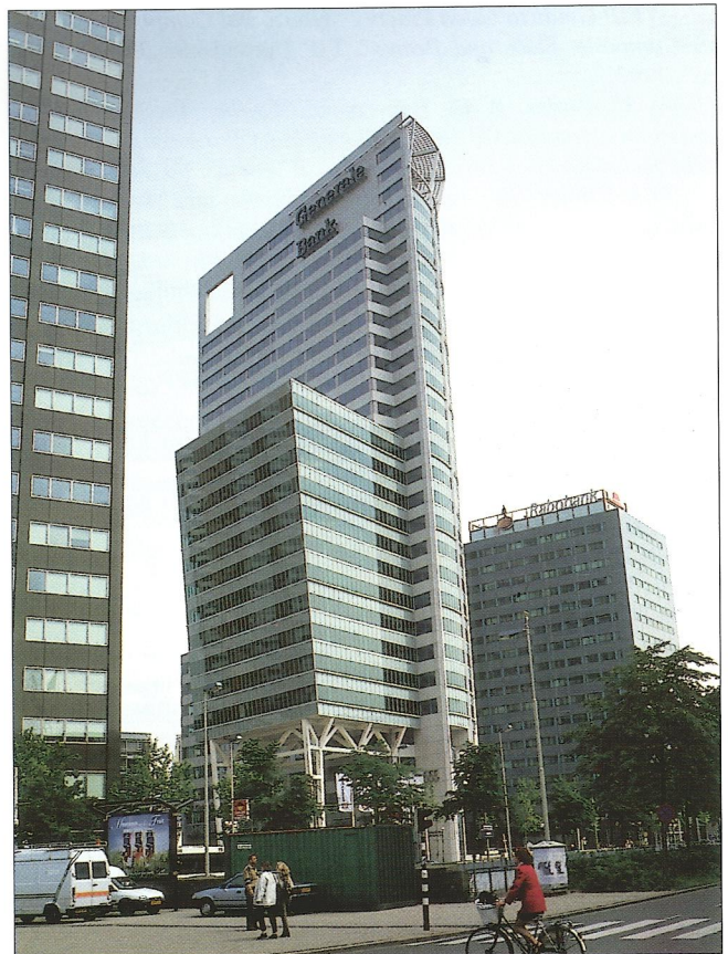
Obr. 19 – Centrální banka v Rotterdamu / Generale Bank Nederland NV in Rotterdam
