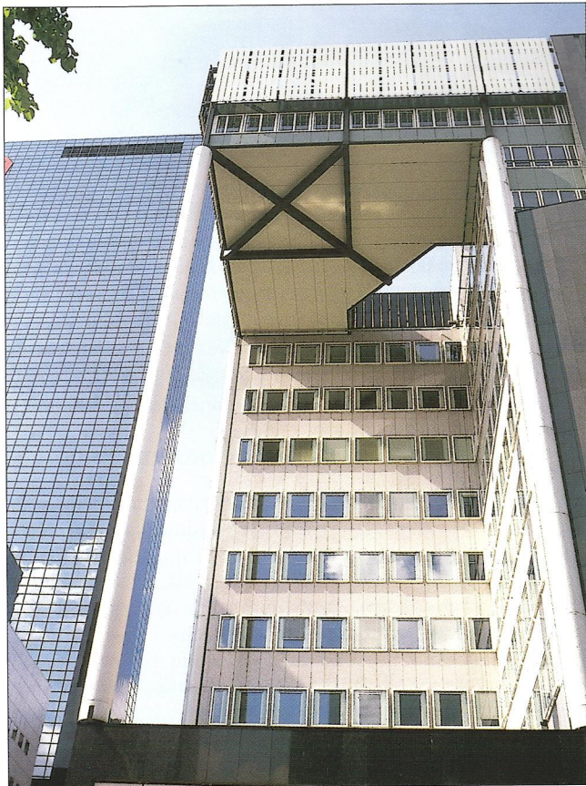
Obr. 18 – Administrativní budova s použitím dutinových stropních panelů v Rotterdamu / An office building in Rotterdam with hollow core floor slabs
