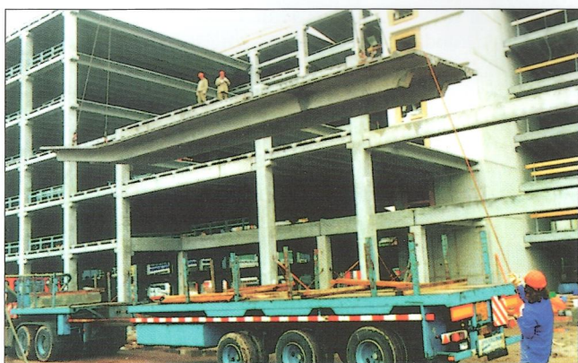
Obr. 13 – Montáž panelů TT parkingu Akademické nemocnice vLeidenu / Assembly of TT units. Car park of Academic Hospital in Leiden
