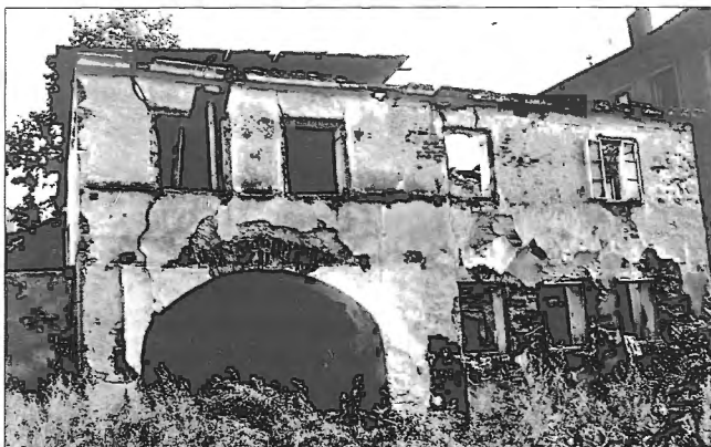
Obr. 5 – T. Vaněk: Památkově chráněný (!) objekt s mnohaletou nulovou údržbou jako doklad poznatku, že největším nepřítelem staveb je voda a člověk. Objekt však zbourán nebyl, sanace stála nemalé prostředky / A heritage building damaged by lack of maintenance and by water; the building has not been demolished, though its rehabilitation was very expensive
