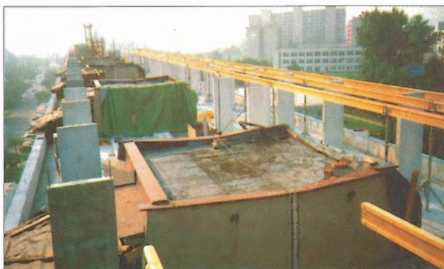
Obr. 7 – Montáž krátkých stěn / Precast wall assembly
