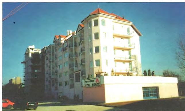
Obr. 1 – Celkový pohled na tři hotové sekce obytného souboru / The general view of three finished buildings of housing estate
