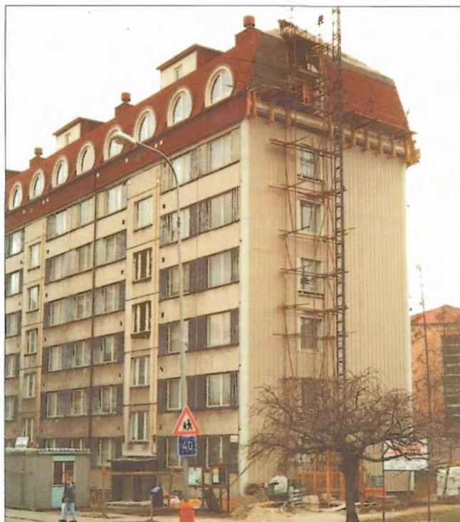
Obr. 10 – Pohled na štít po montáži stropu a parapetů / View of gable erection of floor slab and parapet panels
