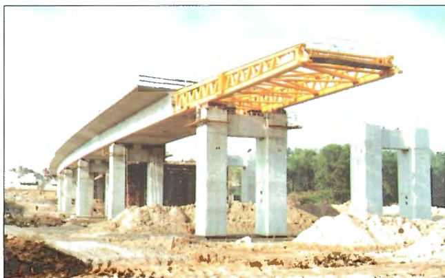
Obr. 4 – Postupné vysouvání nosné konstrukce mostu / Incremental launching of the bridge superstructure
