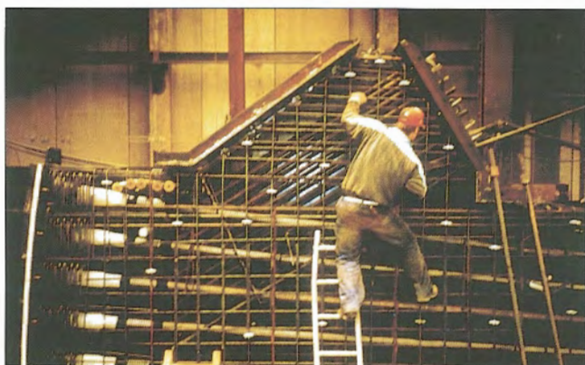
Obr. 5 – Detail styku ocelového ztužidla s monolitickým rohovým sloupem / Detail of connection steel bracing to the cast in situ corner column
