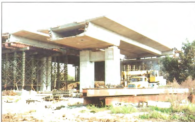
Obr. 5 – Pevná skruž částí mostu nad železniční tratí / Fixed scaffolding of the part of the bridge crossing the railway
