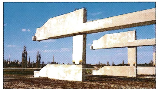
Obr. 9 – Rámová příčle – detail / Assembly of frame beam with console – detail
