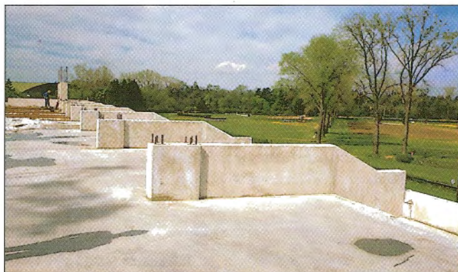
Obr. 16 – Uspořádání konzolové části posledního podlaží / Arrangement of upper floor part of stand
