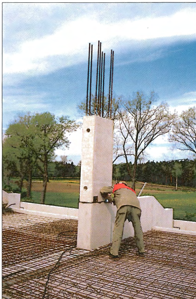
Obr. 11 – Sloup průřezu 0,3 / 0,7 m při montáži / Column of 0,3 / 0,7 m cross-section – assembly
