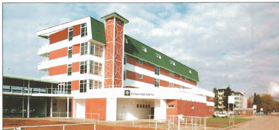
Obř. 3 – Pohled na tribunu od jihozápadu / The southwest view of the stand
