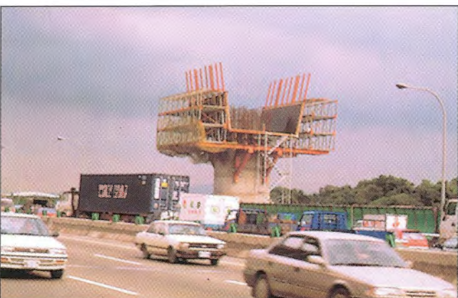
Obr. 16 – Stavba zárodku / Construction of the pier table
