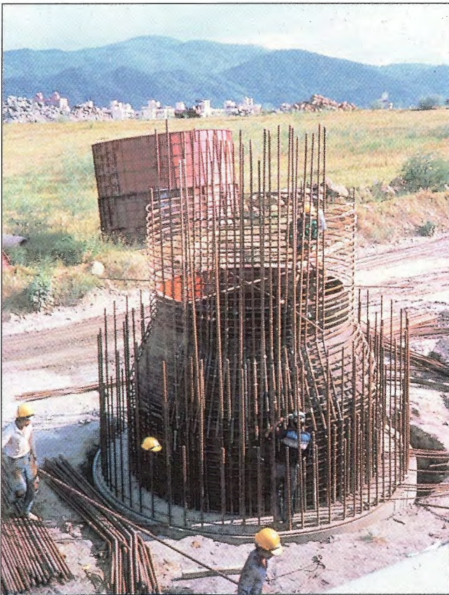
Obr. 11 – Betonářská výztuž pilíře / Reinforcing steel of the pier
