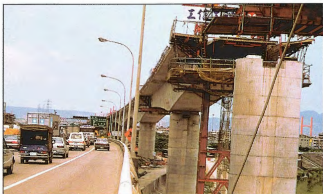
Obr. 7 – Dilatační pilíř / Expansion pier
