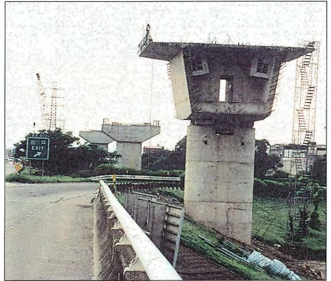
Obr. 17 – Zárodek / Pier table
