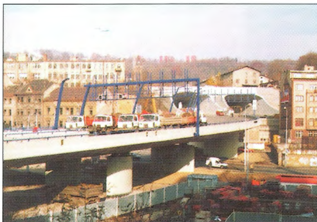
Obr. 7 – Zatěžovací zkouška mostu / Load test of the bridge
