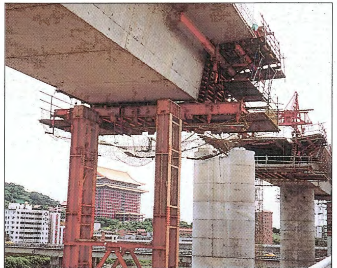
Obr. 18 – Montážní podpěra v krajním poli / Temporary tower in the side span
