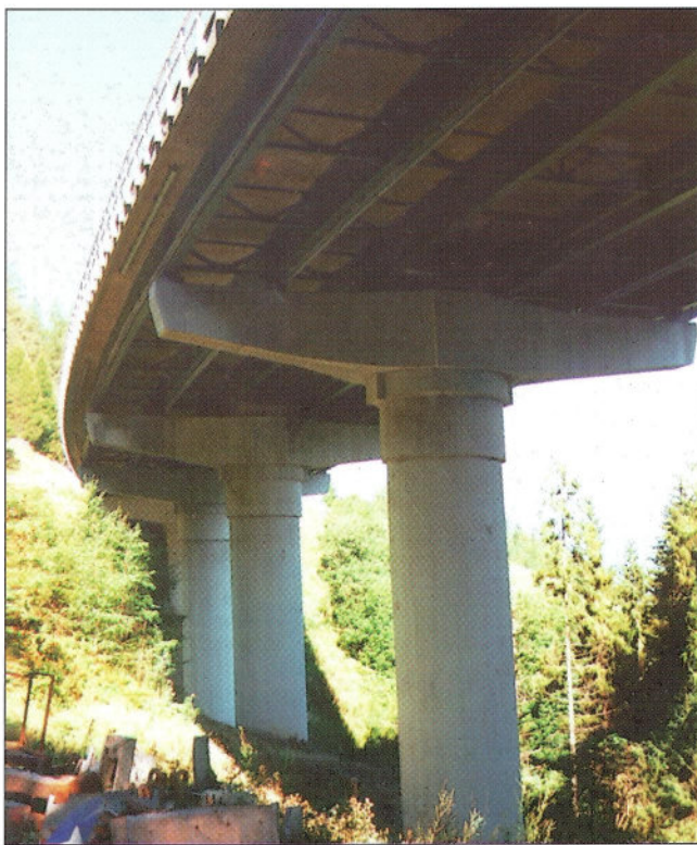
Obr. 2 – Spřažený most na dálnici Innsbruck – Brenner / Composite bridge on the motorway Innsbruck – Brenner
