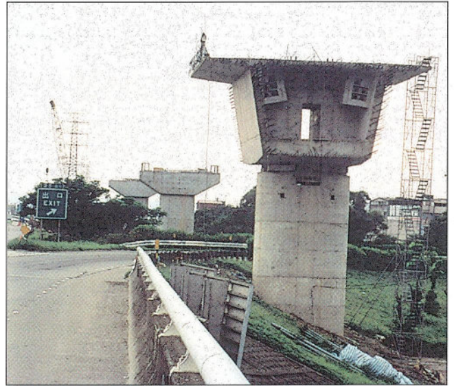
Obr. 17 – Zárodek / Pier table
