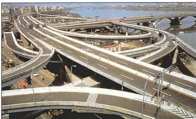
Obr. 3 – Dálniční křižovatka poblíž Taipei / Freeway junction near Taipei
