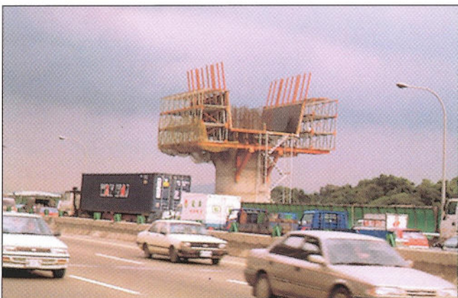
Obr. 16 – Stavba zárodku / Construction of the pier table
