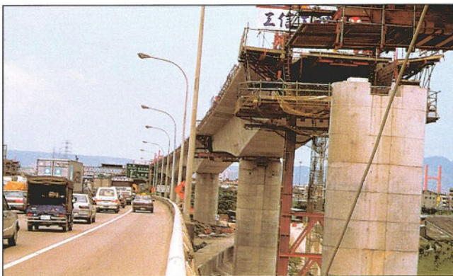
Obr. 7 – Dilatační pilíř / Expansion pier
