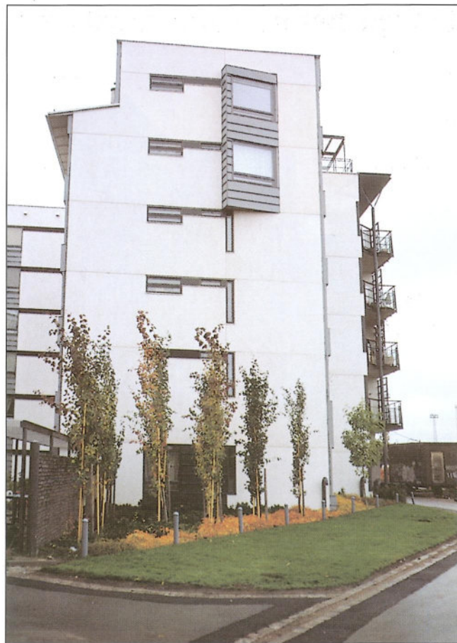
Obr. 12, 13 – Příklady použití velkoplošných obvodových vrstvených panelů v různých úpravách / Sample uses of large sandwich panels of different designs
