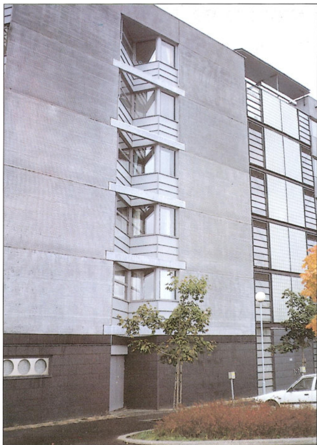
Obr. 12, 13 – Příklady použití velkoplošných obvodových vrstvených panelů v různých úpravách / Sample uses of large sandwich panels of different designs
